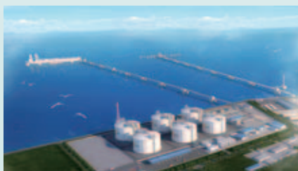
如東洋口港LNG接收站項目
