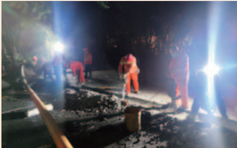
南岸分公司分挑燈夜戰搶建方艙醫院 施工現場
