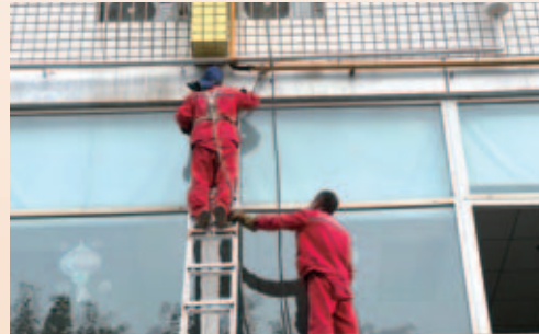
沙坪壩分公司8個晝夜完成600餘間防疫 隔離用房燃氣改造任務
